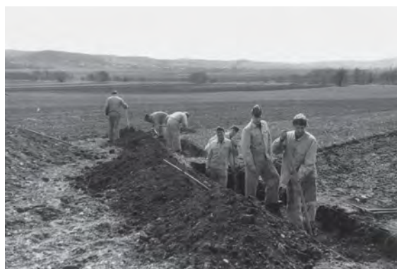
Abb. 10 Soldaten der Kaserne Götzendorf bei den Grabungsarbeiten
