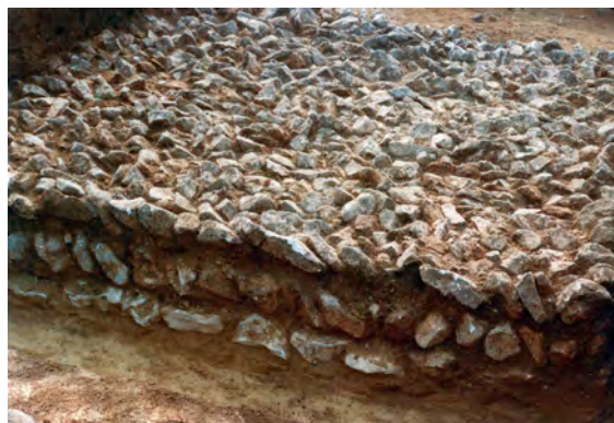
Abb. 30 Objekt 99, Fundament (Detailansicht)
