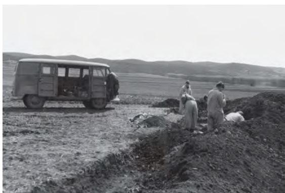
Abb. 9 Soldaten der Kaserne Götzendorf bei den Grabungsarbeiten
